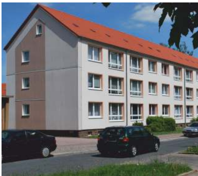
Goethestr. 24-28, Balkonanbau und Fassadensanierung
