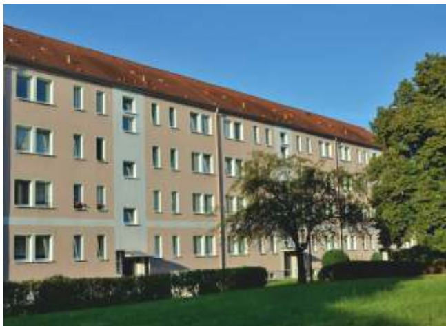
Lauenhainer Str. 11-17, Fassadensanierung
