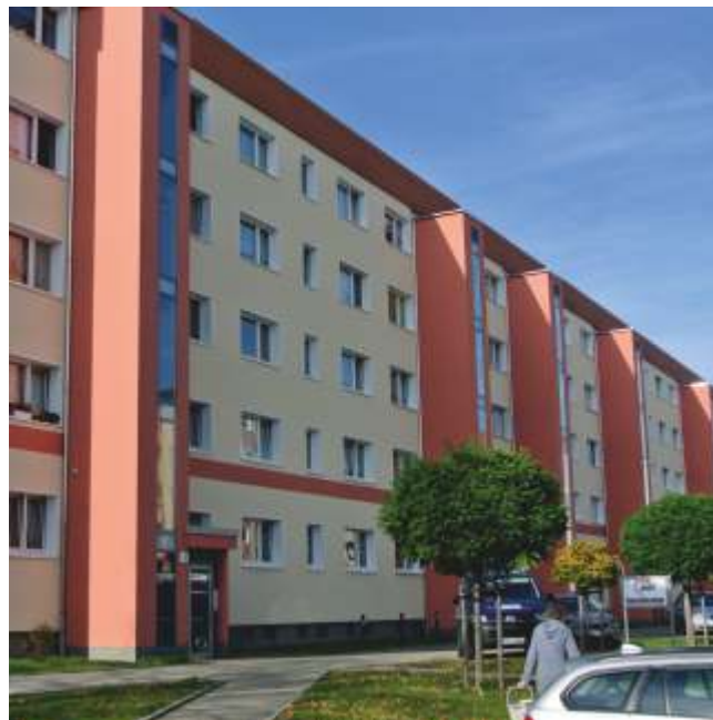
Lauenhainer Str. 43-53, Strangsanierung
