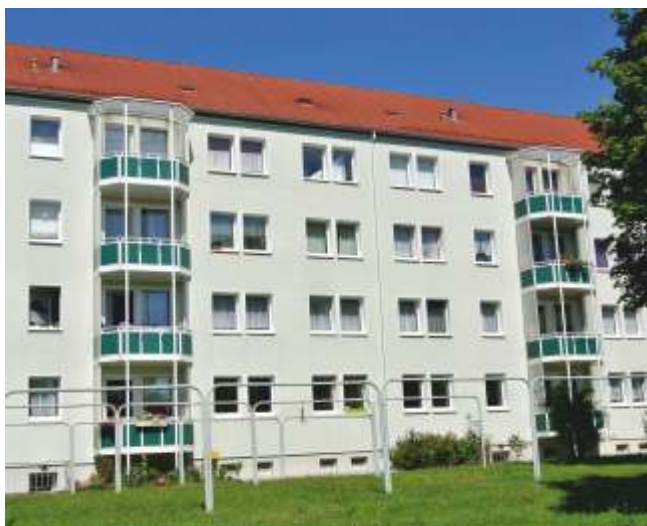
Lauenhainer Str. 35-41, Erneuerung der Warmwasserabsperrentile
