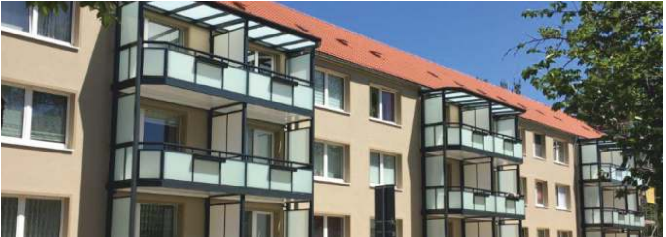
nach Beendigung der Maßnahme „Balkonanbau“
